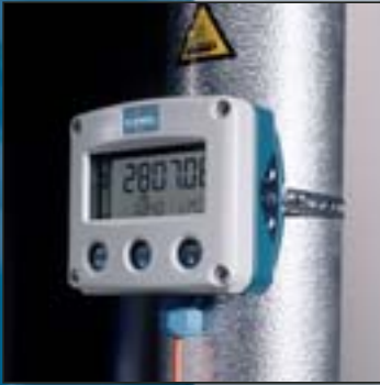
Montering på rør
